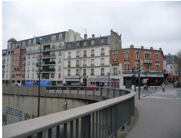
Photo 2 : Vue du quai des Carrières depuis le pont de Charenton
