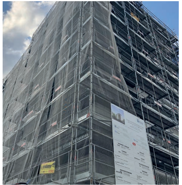
Opération de réhabilitation actuellement menée par Emmaüs Habitat aux 3 et 9, rue Victor Hugo.
