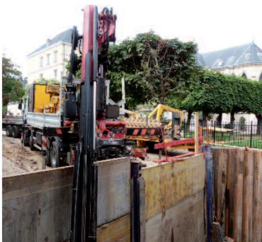
La seconde phase consistera à intervenir sur la partie la plus endommagée du réseau. Elle est comprise entre l'entrée du Parc et le groupe scolaire Notre Dame des Missions - Saint Pierre. Ici, une tranchée de 7 mètres de profondeur ne pourra être évitée afin de remplacer complètement la canalisation. Malgré l'importance de l'intervention, l'accès piéton au parc sera alors maintenu.
