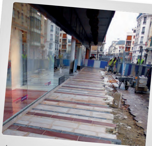
Le chantier du projet "cœur de ville", c'est parti !
