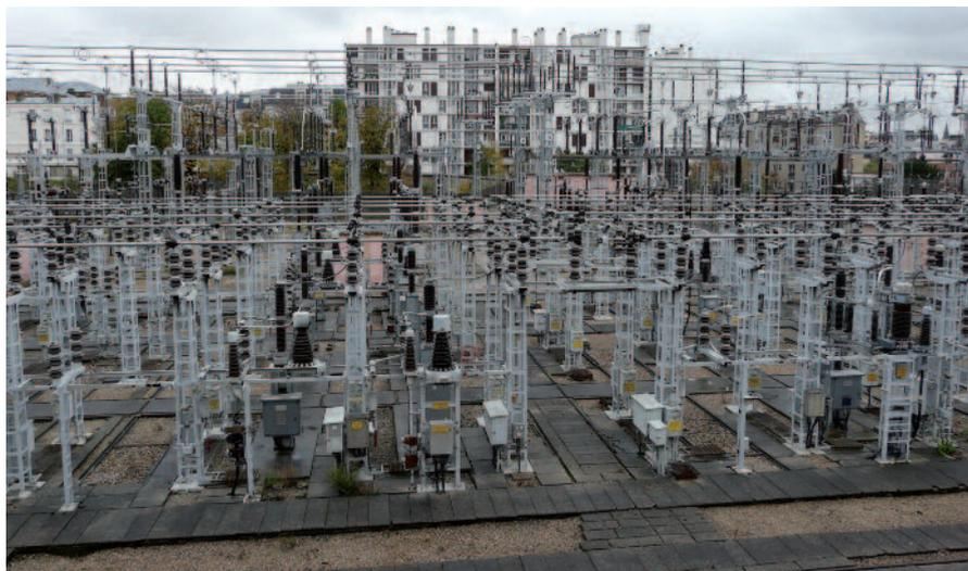
La société Réseau de Transport d'Électricité (R.T.E.) envisage la reconstruction du poste de 63 000 volts de la rue de l'Archevêché à Charenton. Cet équipement, construit dans les années 1950, est essentiel pour l'alimentation en électricité des transports d'Ile-de-France (RATP et RFF) et du centre de traitement des déchets du Sycotom d'Ivry-sur-Seine. Avec le temps, il est cependant devenu obsolète.
