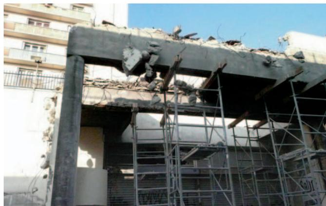
La passerelle Croquette va être dotée d'un nouvel escalier. Le chantier s'est ouvert fin janvier avec la dépose des anciennes marches. Prochaines étapes : mise en place du nouvel escalier choisi ajouré et en ligne droite ainsi que de l'éclairage de la passerelle.
