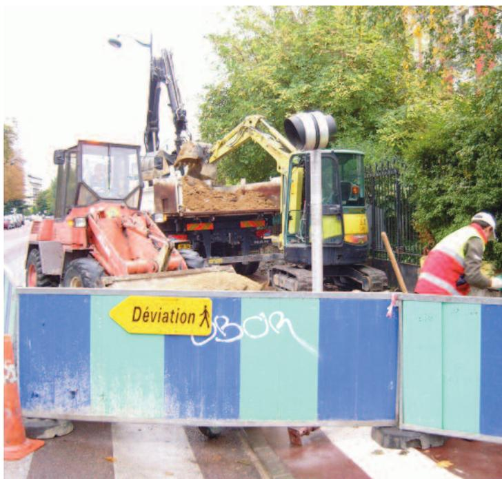
Travaux d'assainissement avenue de Gravelle sur quatre tronçons pour une longueur totale de 188m avec remplacement des canalisations de diamètre 400. Il a par ailleurs déjà été réalisé un tronçon à l'angle de l'avenue de Gravelle et de la rue Jean Jaurès sur 60 m de longueur et un chemisage sur la rue de l'Archevêché entre les rues Kennedy et Jean Pigeon sur 40m linéaire.
