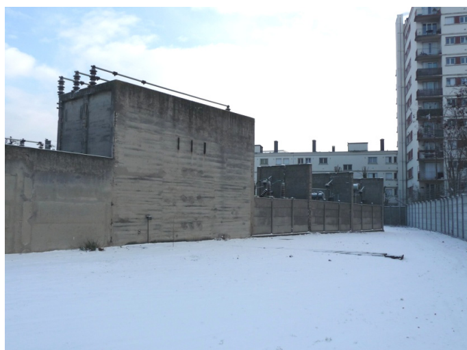
Les BPN qui seront déposées vues depuis le bâtiment de commande actuel
