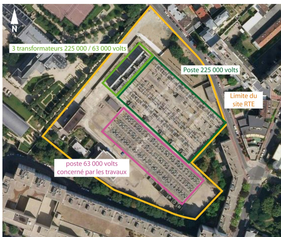
Vue aérienne du site électrique de CHARENTON
