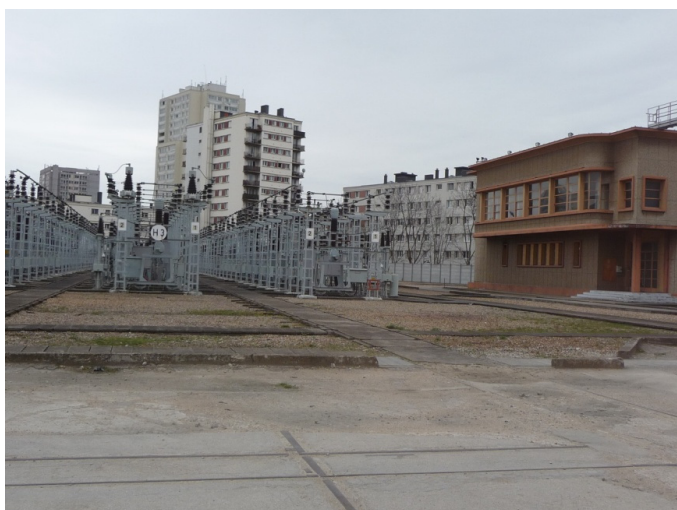
Les installations 63 000 volts et le bâtiment de commande qui seront démolis.
