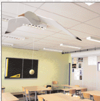
Ecole Robert Desnos : installation de faux plafonds, murs repeints et nouvel éclairage
